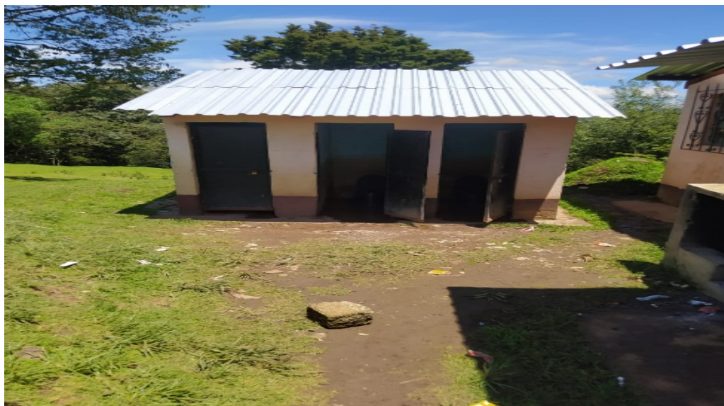
Fig. 14. Letrinas de escuela Chirijcajá, tomada de Proyecto de Filtros Versátiles, CUNOC-USAC/UPNA.
