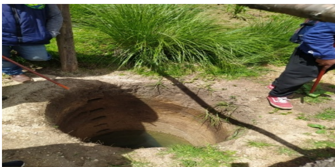
Fig. 10. Pozo artesanal sin tapadera, tomado de Proyecto de Filtros Versátiles, CUNOC-USAC/UPNA.
